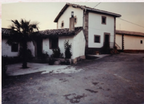
POZA ETA FERNANDORENA ETXEAK
